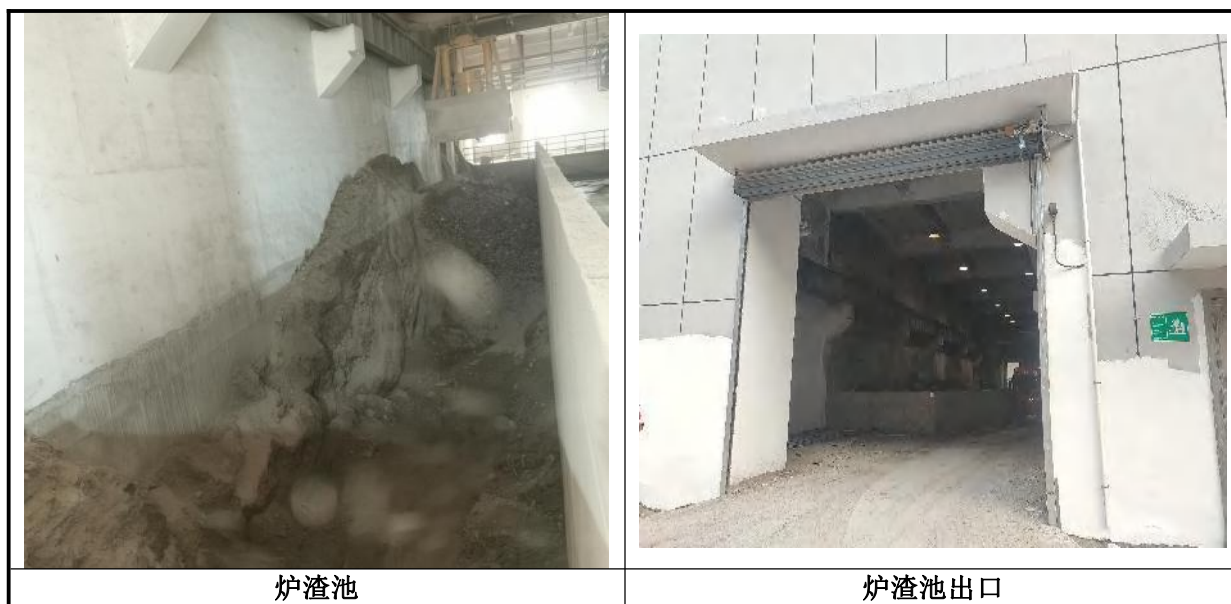
图 4-7 炉渣池现场照片
