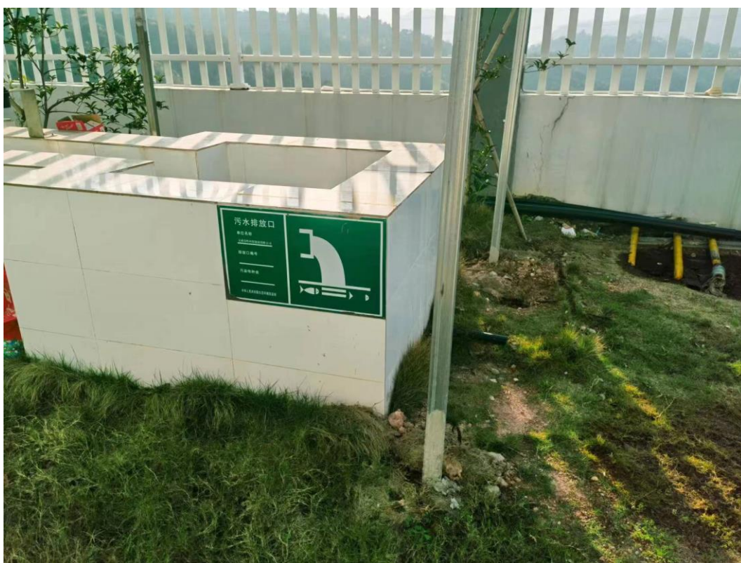
废水排放口现状（已切断外排放管）
