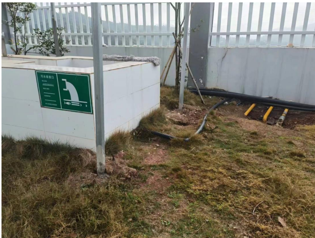
废水排放口建设期状态（排放管已接入管网，未投用）
