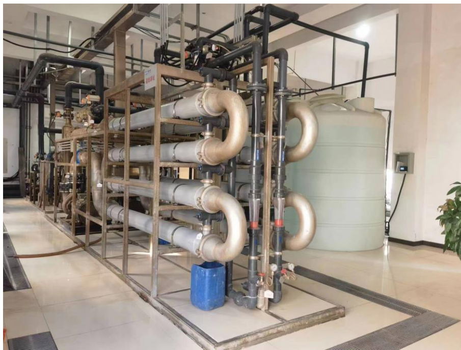
图 2.3-3 垃圾渗滤液处理系统
