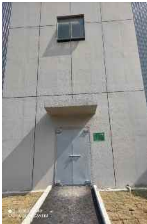
废气处理设施
